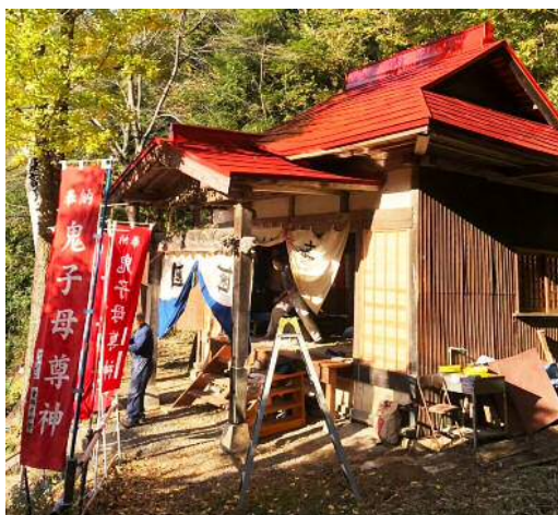
今回修繕したお堂
